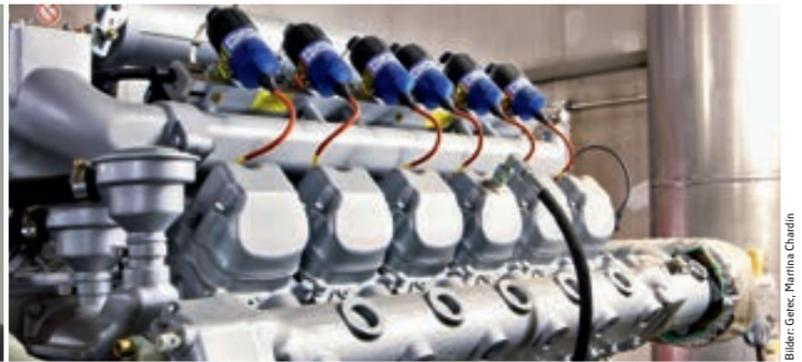
Getec setzt auf KWK: Bei Eigenversorgung – wie mit einem 227-kW-BHKW im Krankenhaus Mettmann – mit Erdgas, bei Netzeinspeisung mit Grüngas
